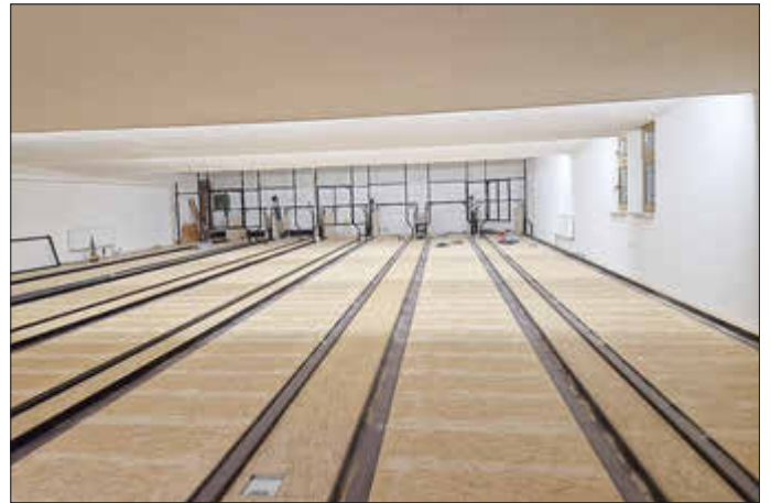
Fehlwurfrinnen, Automaten- und Sichtwandträger sind montiert.
