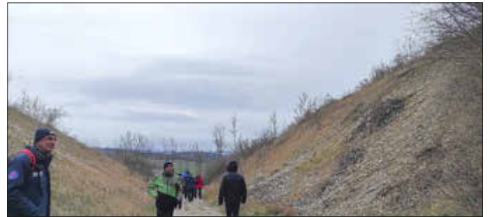
Ein ehemaliger Durchlass unter der Autobahn 4
