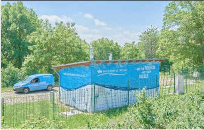
In Regenüberlaufbecken wie diesem an der Werdauer Straße in Zwickau kann Mischwasser bei starken Regenfällen gespeichert und gezielt ins Kanalsystem abgeleitet werden. So wird vermieden, dass Kanalisation und Kläranlagen überlastet werden. Quelle: Wasserwerke Zwickau GmbH – Foto-Atelier Lorenz
